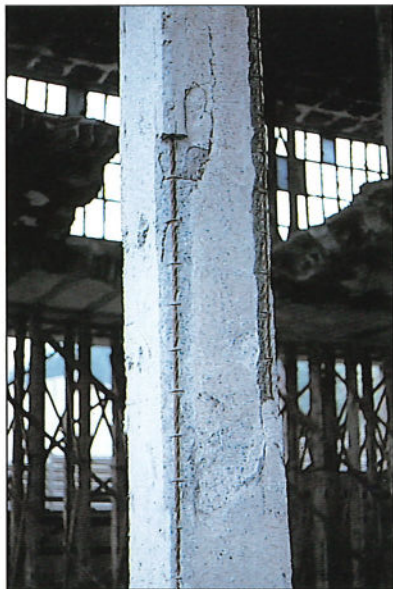
2. DESCATILLADO DE ARISTAS EN PILARES POR DILATACIÓN DE ARMADURA. 2. SPALLING OF COLUMN EDGES DUE TO EXPANSION OF REINFORCEMENT.
