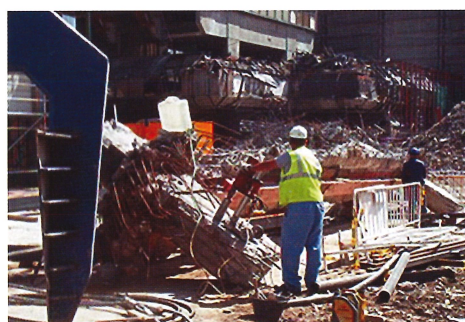
Figura 24. Extracción de testigos en pilares antes de la demolición y en elementos ya desmontados Figure 24. Removing core samples from columns prior to demolition and in members after removal
