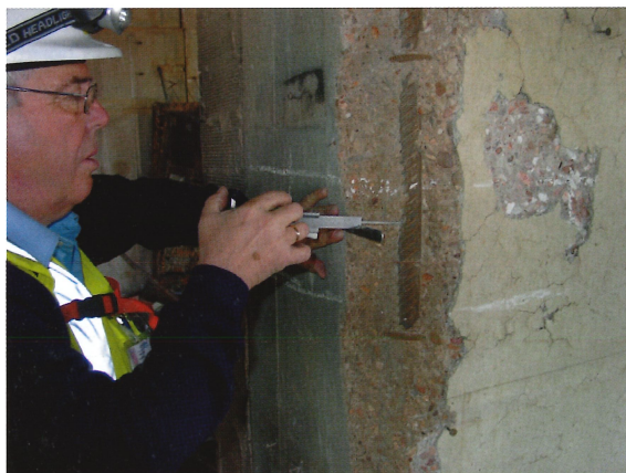
Figura 22. Medida del espesor del recubrimiento Figure 22. Measuring cover thickness
