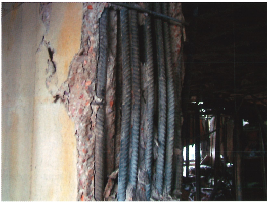
Figura 17. Pandeo de armaduras y rotura de estribos en pilar de planta 8 Figure 17. Buckled bars and broken stirrups in an 8 th storey column
