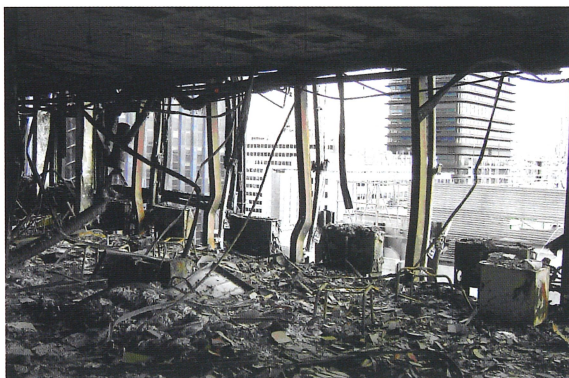
Figura 15. Pilares metálicos de fachada pandeados en Planta 9 Figure 15. Buckling in 9 th storey steel facade columns
