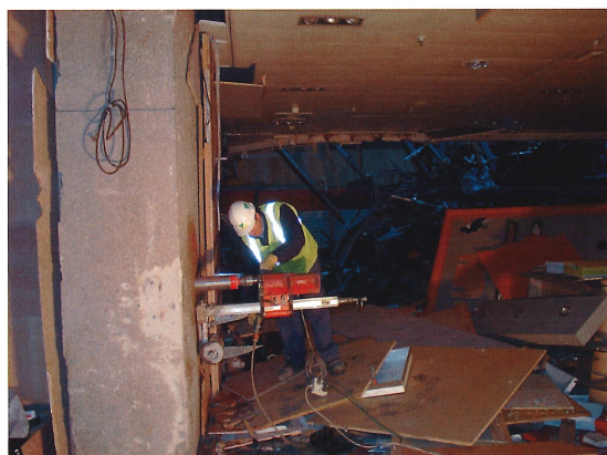
Figura 24. Extracción de testigos en pilares antes de la demolición y en elementos ya desmontados Figure 24. Removing core samples from columns prior to demolition and in members after removal
