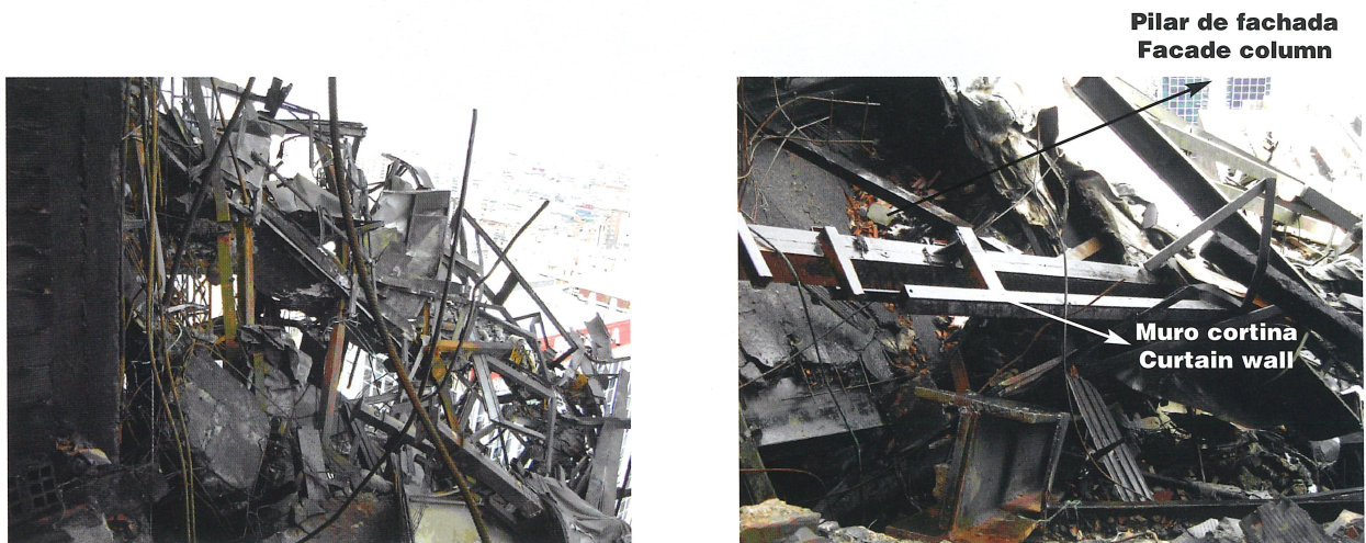
Figura 14. Escombros en Pls 20 y 21. Se aprecian pilares de fachada no ignífugados Figure 14. Rubble on storeys 20 and 21 containing non-fireproofed facade columns
