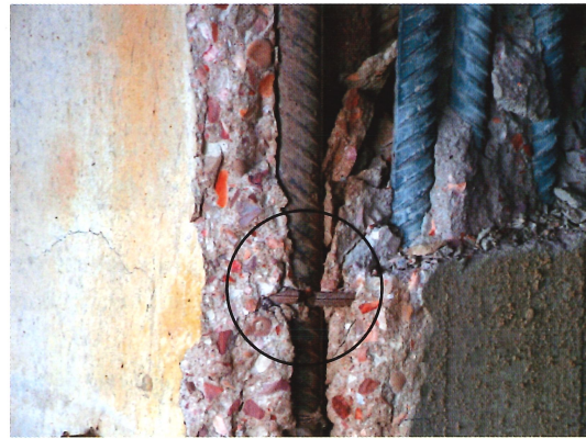
Figura 17. Pandeo de armaduras y rotura de estribos en pilar de planta 8 Figure 17. Buckled bars and broken stirrups in an 8 th storey column
