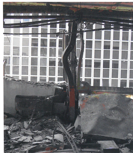
Figura 15. Pilares metálicos de fachada pandeados en Planta 9 Figure 15. Buckling in 9 th storey steel facade columns
