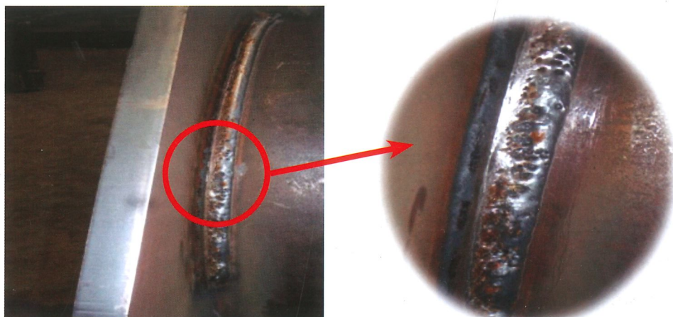
Figura 26. Defecto de Porosidad agrupada Figure 26. Linear porosity
