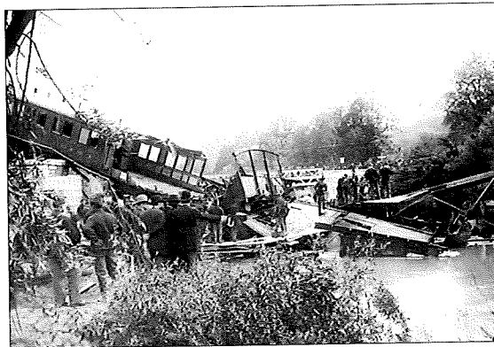
Fotografía 3. Puente de Mönchenstein Photograph 3. Mönchenstein Bridge
