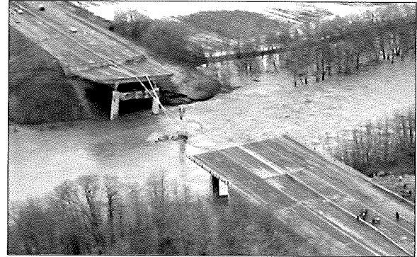
Photograph 14 (I). Schoharie Creek Bridge before and after the accident Fotografía 14 (I). Puente Schoharie Creek antes y después del siniestro.
