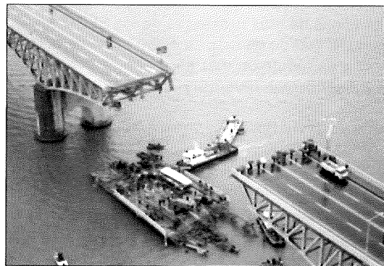
Photograph 14 (II). Seongsu Bridge Fotografía 14 (II). Puente de Seongsu
