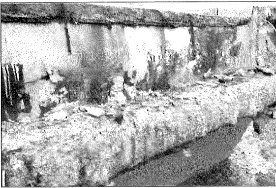
Photographs 31 and 32. Halved joint where the accident was induced Fotografías 31 y 32. Junta a media madera donde se inició el siniestro
