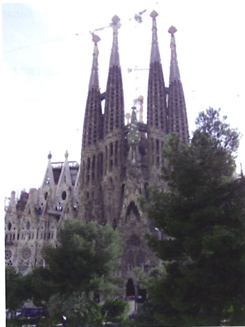
Figura 5: Fachada del Nacimiento Figure 5: Nativity Façade
