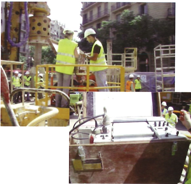
Verification of excavation verticality and integrity with Koden drilling monitor Verificación de la integridad y verticalidad de la excavación mediante el sistema Koden
