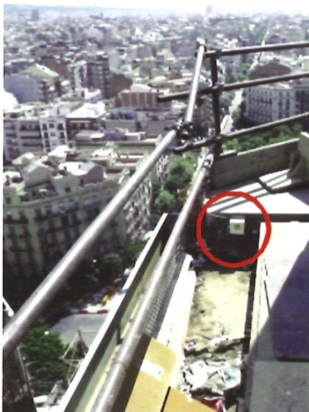
Accelerometer with its protective casing Vista de uno de los acelerómetros colocados, con su carcasa protectora
