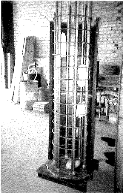
Photograph 7. Rebar and instrument tubes in the test pile Fotografía n° 7. Vistas de las armaduras y tubos de auscultación del pilote de prueba.
