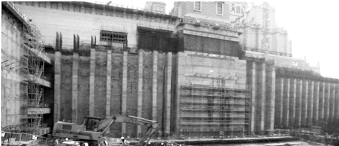
Figure 17. Lining wall and buttress overview and construction Figura 17. Ejecución y vista general del muro forro y contrafuertes
