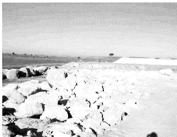
Photograph 6. Rock fill material Foto 6. Material tipo "pedraplén"
