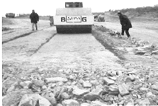
Photograph 1. Test fill construction Foto 1. Tramo de ensayo en ejecución
