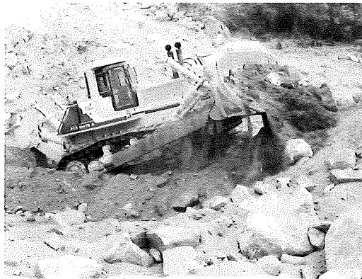
Photograph 7. Ripping random fill material Foto 7. Extracción de material tipo todo-uno mediante "ripado".
