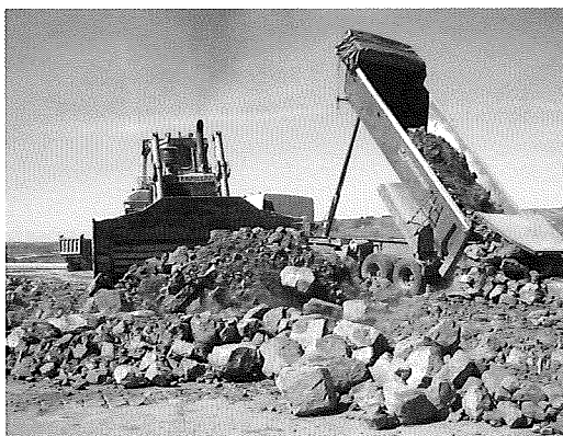
Foto 8. Detalle de frente de extendido Photograph 8. Detail of spreading front
