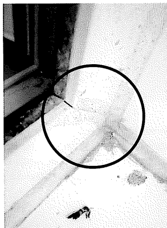
Fotografía nº 2: Detalle de un sellado de encuentro de perfiles realizado "a posteriori". Obsérvese su superficialidad. Photograph 2: detail of profile joint, sealed a posteriori. Note that the seal is superficial.
