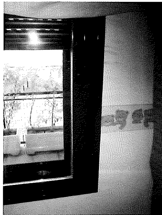
Photograph 23: draught marks around joinery edges. Fotografía n° 23: Marcas de entradas de aire por borde de carpintería.
