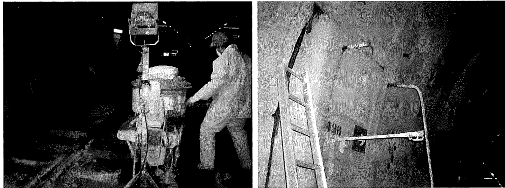
Fotos 3 y 4. Inyecciones de impermeabilización posterior en un túnel de dovelas.
