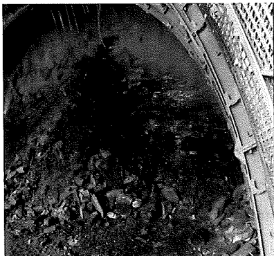
Figura 2. Sección tipo sostenimiento-impermeabilización en terreno quebradizo
