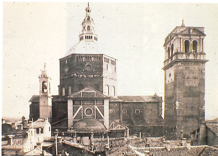
Foto 2. La Catedral y la Torre Civica colapsada en Pavia en 1989.
