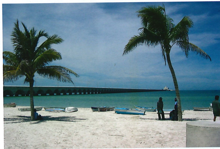
Figura 11: El muelle de Progreso, (Méjico) de 65 años de antigüedad
