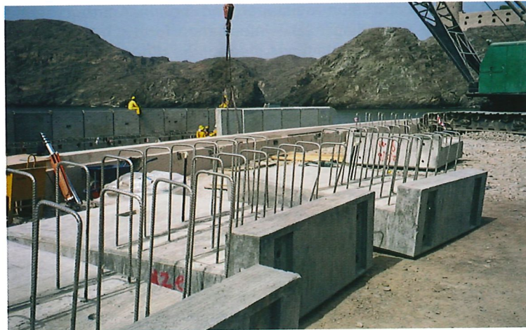
Figura 15: Uso de la armadura de acero inoxidable en los elementos estructurales prefabricados para sustituir un dique dañado por la corrosión que protege el Palacio y el nuevo complejo destinado al Palacio de Invitados (Figura 14) del Golfo de Omán.
