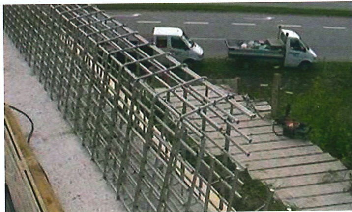
Figura 16: Sustitución de las vigas del borde y de los petos de los puentes de Dinamarca expuestos a la sal para el deshielo. Se introduce armadura de acero inoxidable para evitar futuras reparaciones que podrían causar graves problemas de tráfico. Asimismo, las nuevas estructuras están incorporando armadura inoxidable en las vigas del borde y los petos dado que están muy expuestas a las sales para el deshielo en los meses de invierno.
