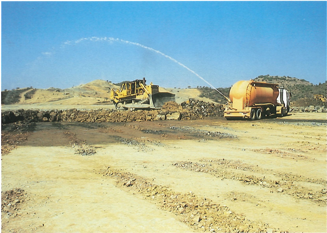
3-Extendido de una capa. Spreading of a layer.
