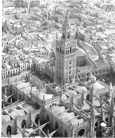
Cubiertas Catedral de Sevilla. Postal 1.996 Roof on Seville Cathedral. 1996 post card Fig. 9
