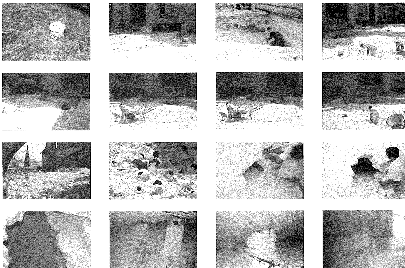
Inspección-excavación Bóveda de San Antonio. Catedral de Sevilla. Arquitecto mayor Alfonso Jimenez Inspection-excavation of Ft. Anthony vault. Seville Cathedral. Resident architect Alfonso Jimenez Fig. 19
