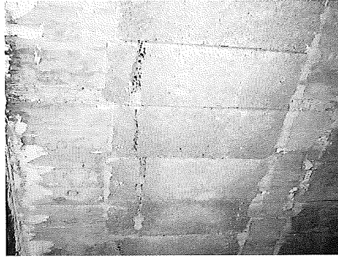
Fisuras en fondos de bovedillas por la flexión de las vigas de pórticos Cracks in bottoms of pan forms due to portal frame beam bending Fig. 25
