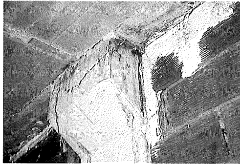
Daños en una ménsula para apoyo de un paño de forjado Duct broken due to work site traffic Fig. 13
