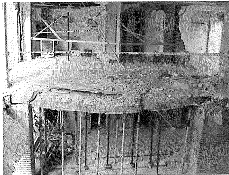
Efecto de una explosión en un edificio de viviendas Effect of an explosion on an apartment building Fig. 63
