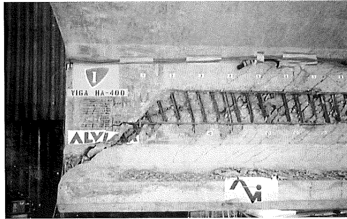
Figura 2.1. Rotura por compresión en las bielas de cortante. Ensayos realizados por Intemac en Madrid. Figure 2.1. Shear strut compression failure. Trials conducted by Intemac at Madrid.
