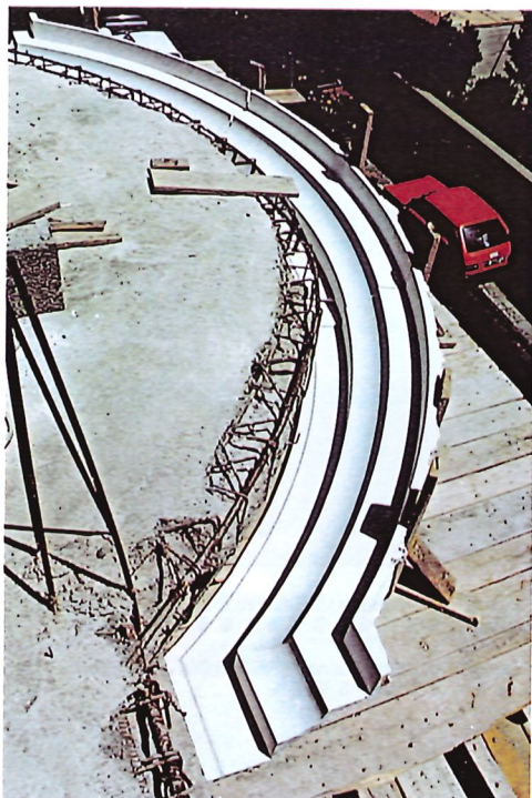
Encofrado de cornisa en escayola. Corresponde a la muestra n.º 20.
