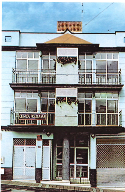
Local comercial y cuatro viviendas. Cemento Gris PA-350. Cornisas: 3 % Negro Gloria Scharlau.
