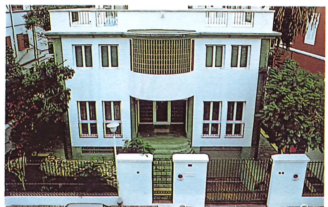
Vivienda unifamiliar. Cemento Gris PA-350. 2 % Verde Luz 5G Bayer.
