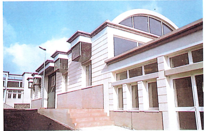
Encofrados de tableros de madera de densidad media en zócalos, el de la cornisa de madera de pino natural.
