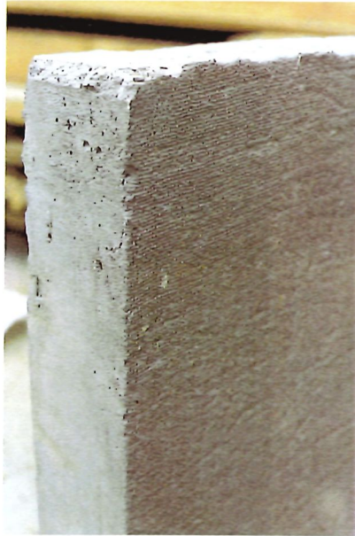
Encofrado con tejido de arpillera. Formwork with sacking.
