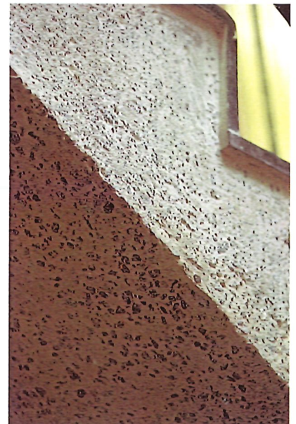
Abujardado a martillina mecánica. (Arido fonolítico de machaqueo.)
