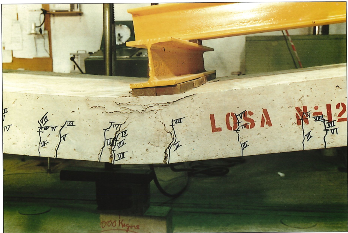
Foto 4. Detalle rotura plástica formada en losa 12 (armada con acero de alta ductilidad). Photo 4. Detail plastic hinge in slab 12 (reinforced with high ductility steel).
