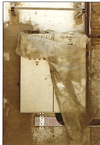
Fotografía N° 10. Cuadro eléctrico situado en intemperie, no preparado para esta ubicación. Photograph No. 6. Fire protection control panel juggled to disable an alarm.
