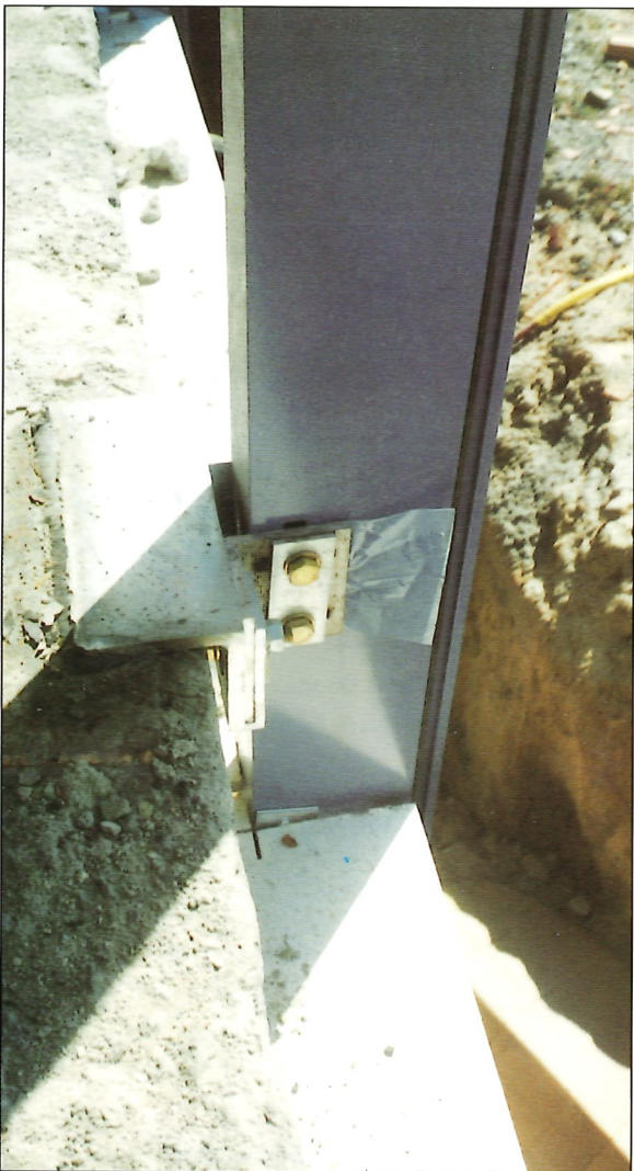
Fotografía N° 10. Anclaje. Photograph No. 10. Connections.
