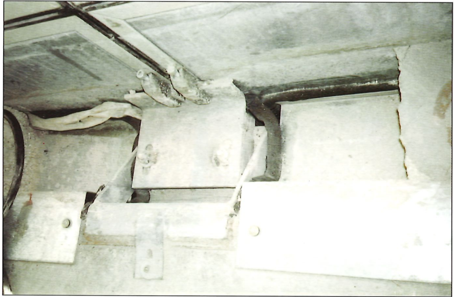
Fotografía N° 9. Ajuste de los paneles por tornillería. Photograph No. 9. Leveling bolts.
