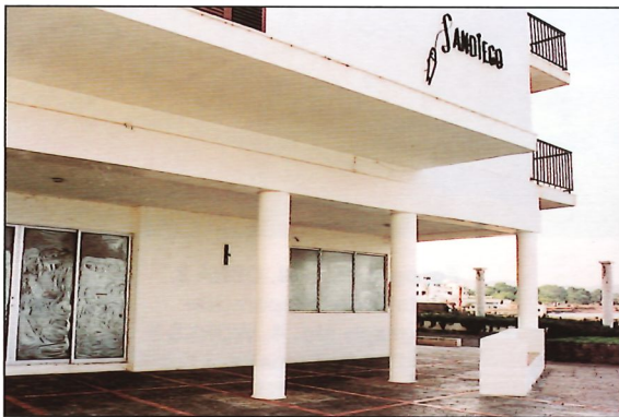
Fotografía nº 9. Pilares reparados en la OBRA 7. Photograph No. 9. Columns repaired in WORKS 7.
