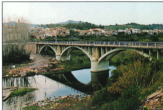
Fotografía nº 2. OBRA 2. Photograph No. 2. WORKS 2.
