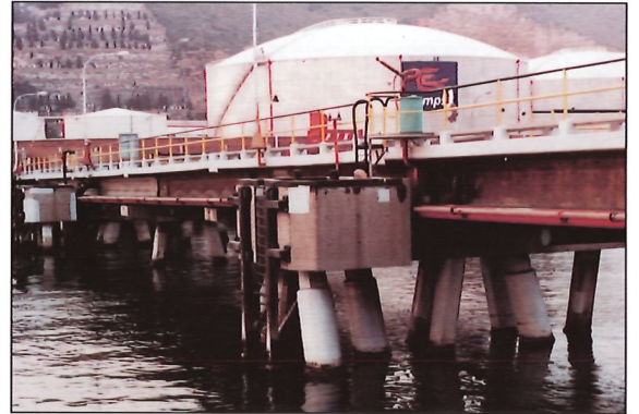
Fotografía nº 8. OBRA 6. Detalle de reparaciones en cabeza de pilotes y cabeceros. Photograph No. 8. WORKS 6. Detail of repairs on piles and wallings.
