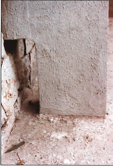
Fotografía nº 7. OBRA 5. Detalle de la base de un pilar Photograph No. 7. WORKS 5. Detail of a column base.
