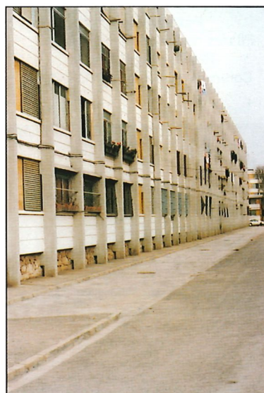
Fotografía nº 6. Aspecto de los pilares reparados en la OBRA 5. Photograph No. 6. View of columns repaired in WORKS 5.
