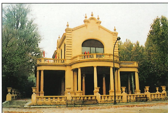
Fotografía nº 5. OBRA 4. Aspecto de la obra reparada. Photograph No. 5. WORKS 4. View of repairs.
