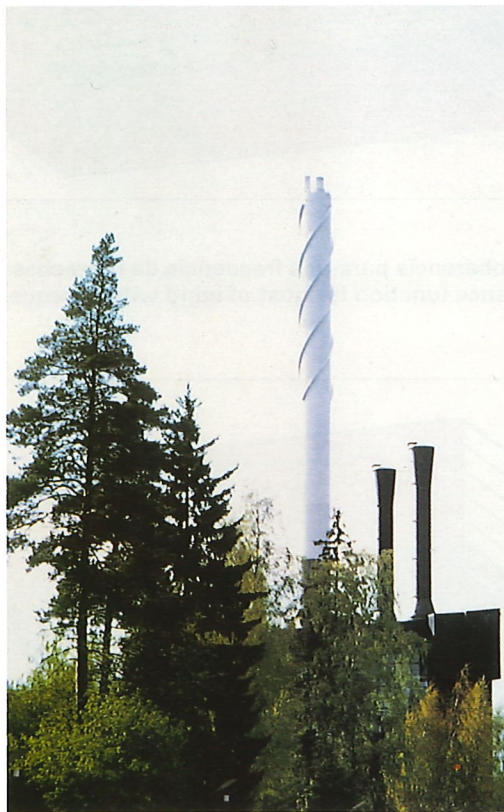
Fig. 6: Chimenea metálica Fig. 6: Metal chimney stack
