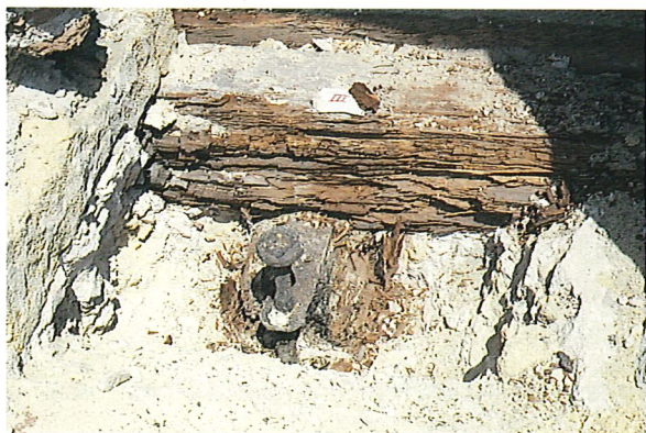
3. PUDRICIÓN CÚBICA PRODUCIDA POR EL MERULIUS . 3. CUBIC SPALLING PRODUCED BY DRY ROT.
