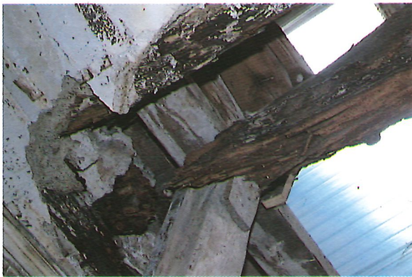
5. PUDRICIÓN PRODUCIDA POR EL CONIPHORA PUTEANS . 5. FIBROUS ROTTING PRODUCED BY THE CONIPHORA PUTEANS .
