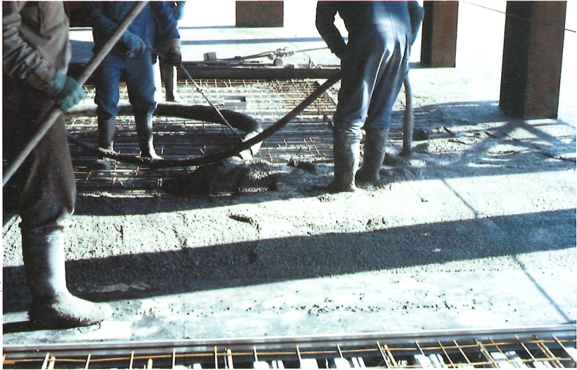
Fotografía n.º 3. Fase de hormigonado. Photograph No. 3. Concreting phase.
