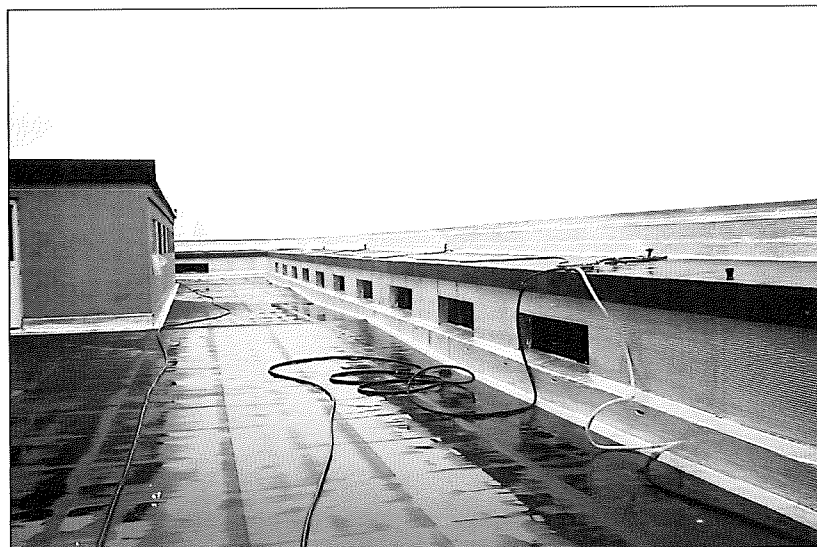
Fotografía 6. Pruebas de estanqueidad al agua mediante riego. Photograph 6. Water penetration testing by spraying.
