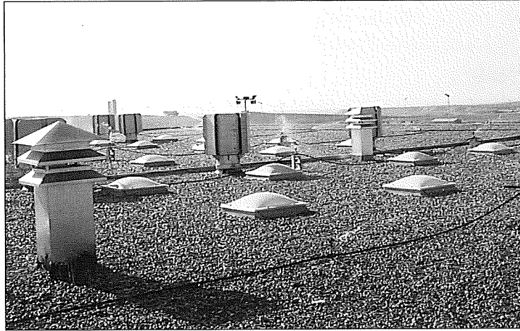
Fotografía 2. Ensayo de estanqueidad al agua en una cubierta no transitable. Photograph 2. Water penetration test on a non-accessible roof.
