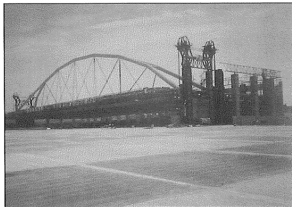
FOTO 10. OPERACION DE IZADO DE LA CUBIERTA DEL HANGAR N° 6 DE IBERIA PHOTO 10. HOISTING OPERATION OF THE ROOF DECK OF IBERIA'S HANGAR No.6
