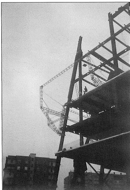
FOTO 12. ALINEACION DE PILARES INCLINADOS DE PUERTA EUROPA PHOTO 12. ALIGNMENT OF INCLINED COLUMNS ON THE PUERTA DE EUROPA
