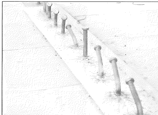
FOTO 7. ENSAYOS SOBRE CONECTADORES SOLDADOS PHOTO 7. TESTING WELDED CONNECTIONS
