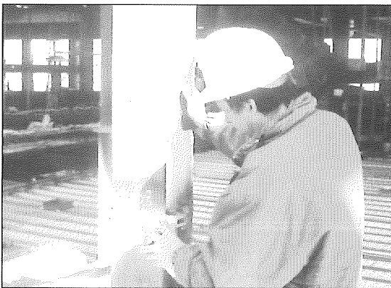
FOTO 6. ENSAYO DE LIQUIDOS PENETRANTES PHOTO 6. DYE PENETRANT TESTING
